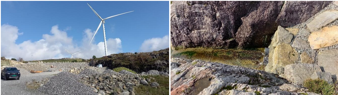
Figur VI-4. Rundt deponi og uttaksområdet som er omregulert (venstre) er det i dag et etablert overvannssystem som skjærer av overvann fra terrenget, og leder det direkte ut i åpent bekkeløp (høyre).
