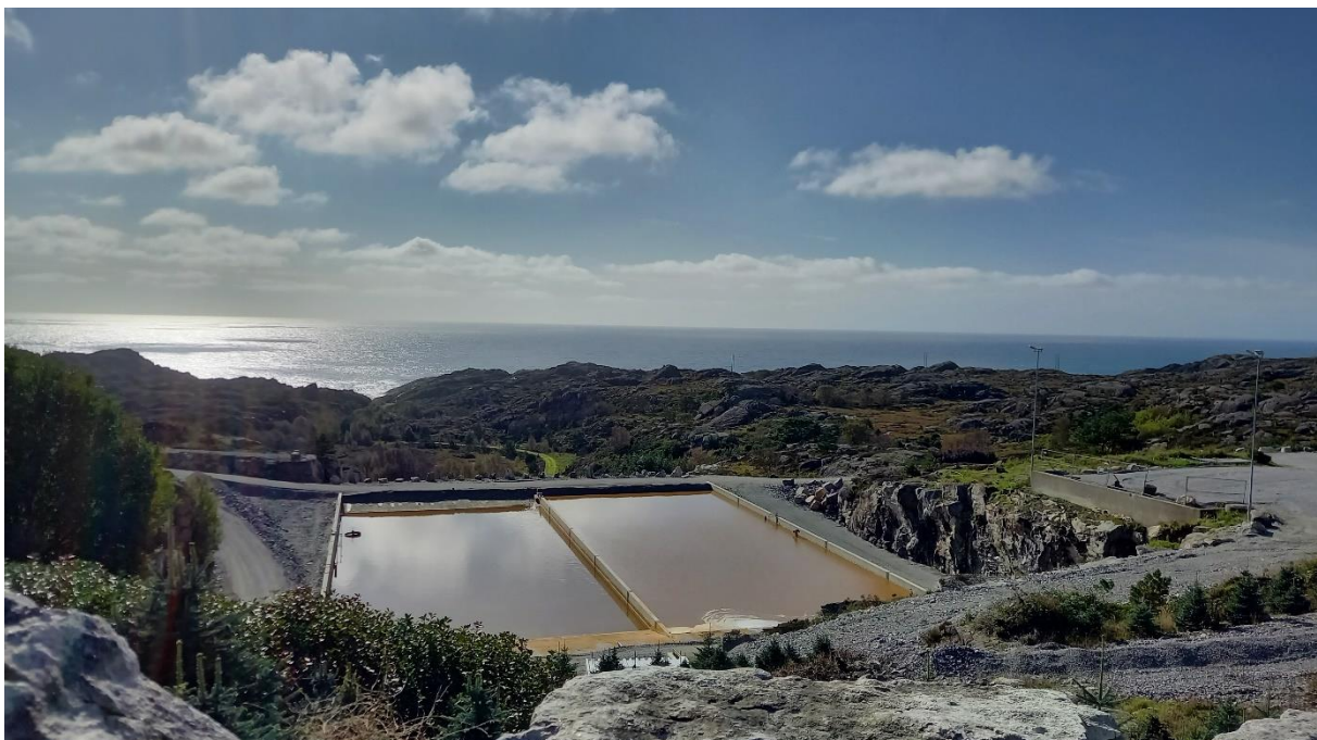
Figur 4-3. Etablert rensedbasseng for sigevann fra dagens aktive deponiområde, med utløpsledning ned mot Bomviga, parallelt med bekken Stølen.
