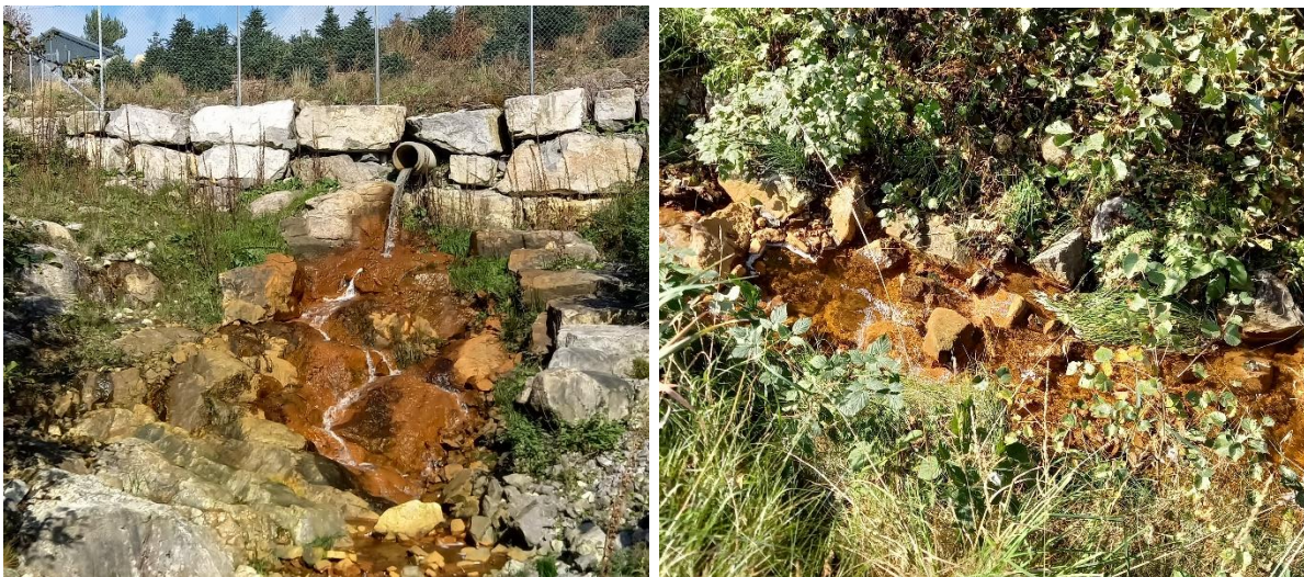
Figur V1-1. Øvre halvdel av vannforekomsten/bekken er rørlagt, og mottar overvann som er avskjermet fra øvre deler av deponiområdet. Jernutfelling er tydelig i øvre del av bekkedunn, når vannet får oksygentilgang.
